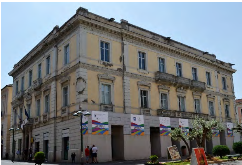
Fig. 1 - Palazzo Bosco Lucarelli, scorcio su via Orbilio Pupillo. Si notino le evidenti patologie di degrado che affliggono le facciate.
