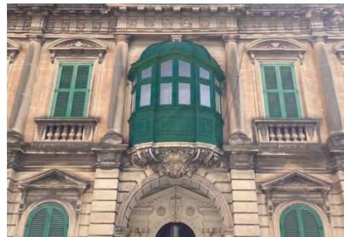
Fig. 10- Particolare tipologia di Gallarija semicircolare con mensola di sostegno riccamente decorata, Mosta, Malta
