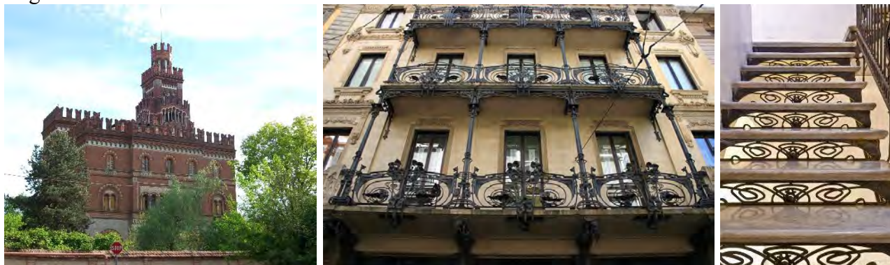
Fig. 1 – A sinistra Villa Crespi a Crespi d'Adda. In centro e a destra Casa Ferrario a Milano
