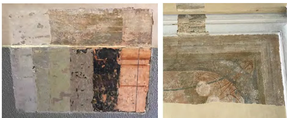
Fig. 5 – A sinistra saggio stratigrafico nei vani scala in corrispondenza del marmorino e dell'intonaco delle pareti. A destra saggio stratigrafico sul soffitto dell'androne.
