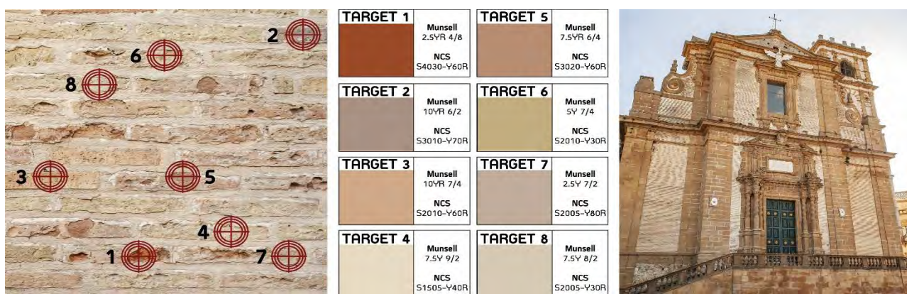
Fig. 5) Il rilievo del colore della cortina in mattoni con sistema diretto color chart Munsell .
