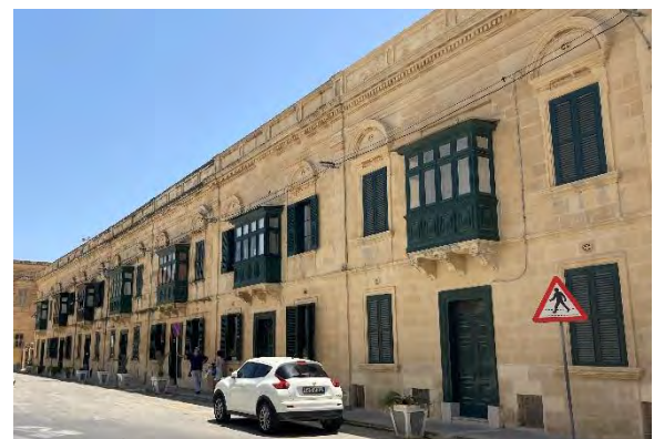
Fig. 6- Serie di edifici vincolati per il loro streetscape in Piazza Sant' Agostino, Vittoria, Gozo
