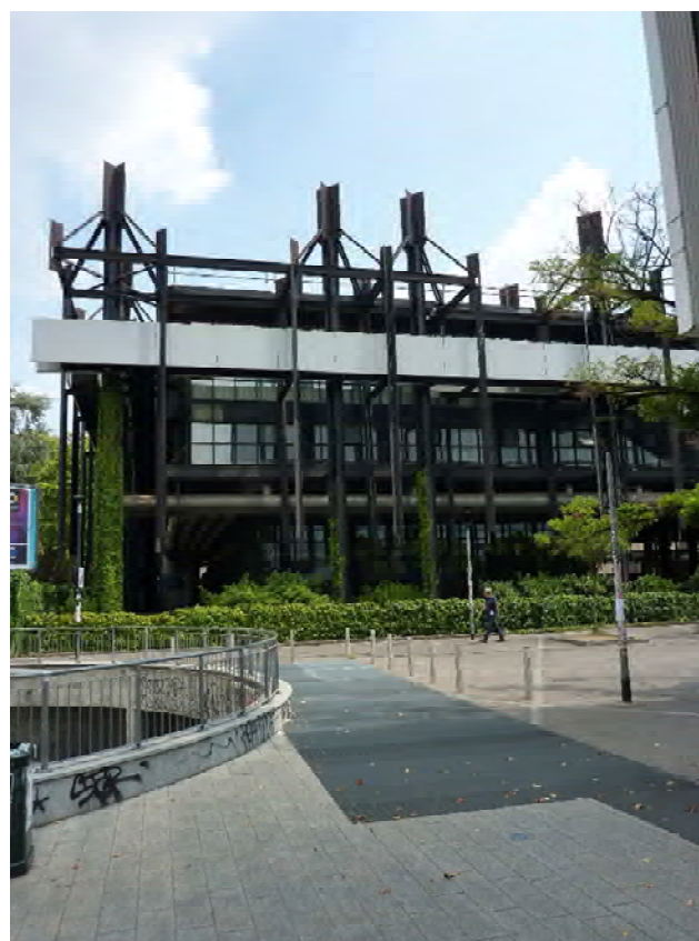
Fig. 10 - edificio via Ampère, Milano
