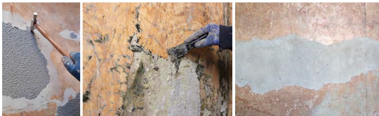
Fig. 6 – Rimozione degli strati sovrapposti con sverniciatore a solvente asportati con raschietti manuali; successiva eliminazione dei residui di lavorazione e sgrassatura tramite solvente a tamponi. Arriccio e marmorino realizzati con malta a base di calce con l'aggiunta di inerti sottili (polveri di marmo), pigmentati a tono con l'originale.
