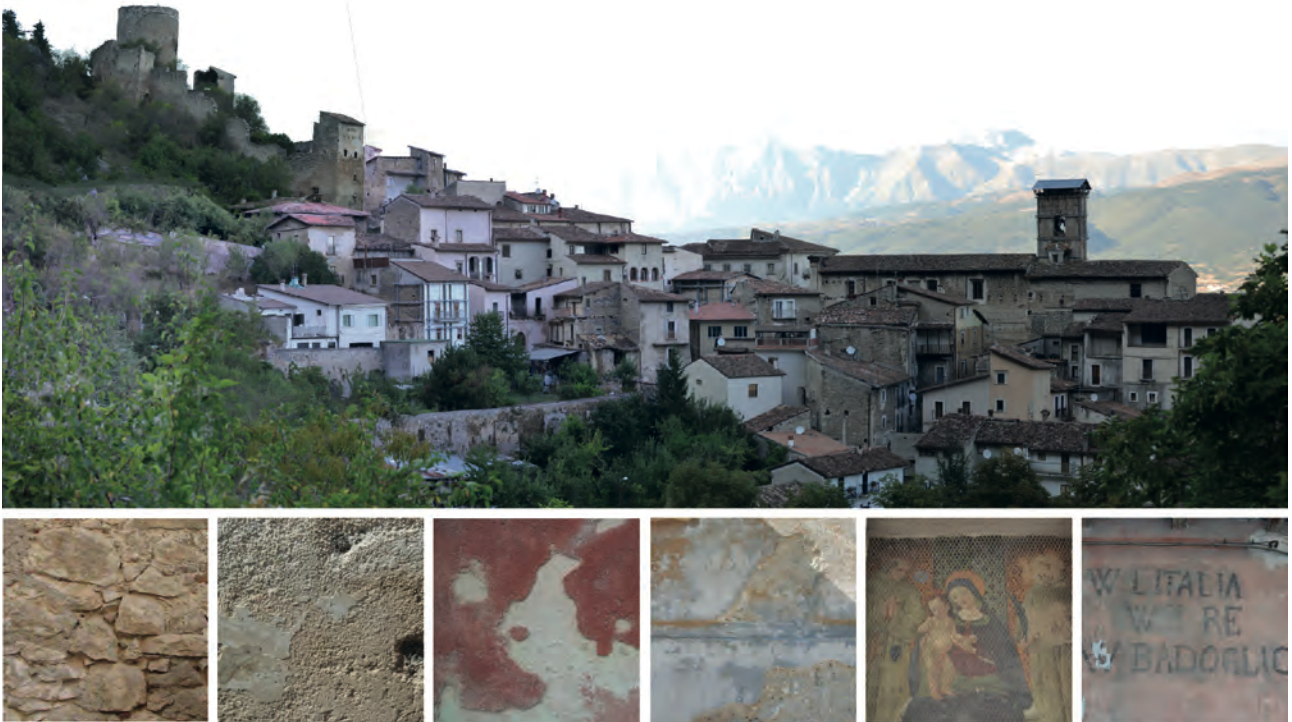
Fig. 3. L'abitato con la chiesa dell'Assunta sullo sfondo. Le coloriture si attestano sulle gamme chiare e la compresenza di tessiture murarie a vista e di paramenti intonacati deriva anche dalla gerarchizzazione delle diverse fronti degli edifici
